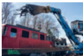
18. März: In Ecublens beginnt bei Thévenaz-Leduc SA der Abbruch der Ae 6/6 «Stadt Basel».
