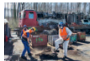
Die grossen Stücke werden mit dem Schneidbrenner von Hand in immer kleinere Teile zerlegt.
